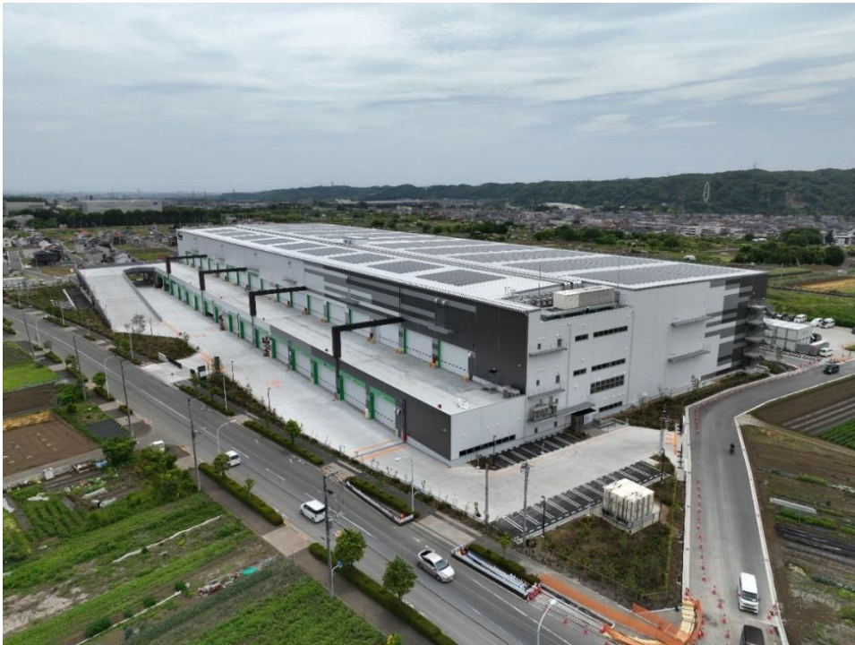
<T-LOGI あきる野 建物外観>
