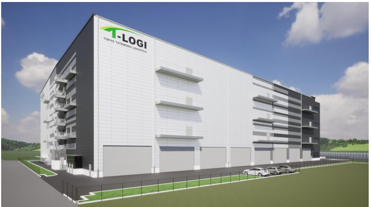
< (仮称) T-LOGI 寒川 建物外観イメージ > ※実際と異なる場合があります
