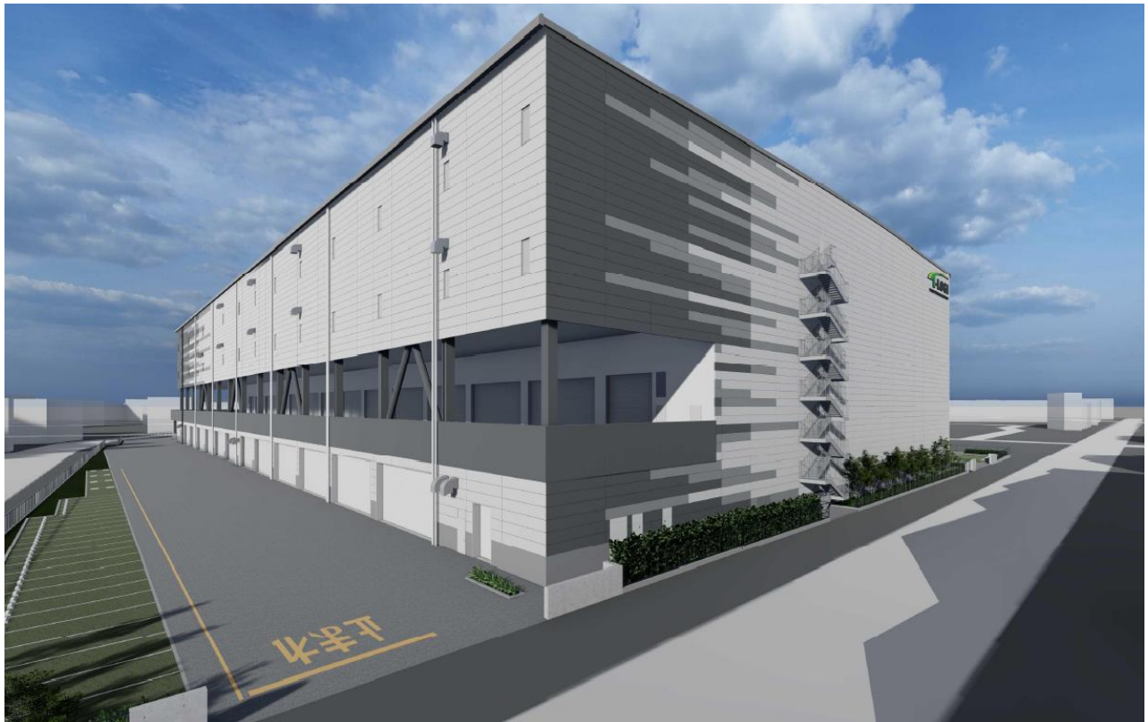
<「(仮称) T-LOGI 白岡」外観イメージ>
